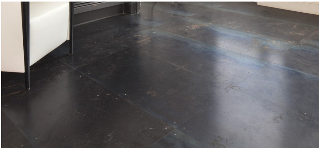
Foto: Voorziening van aan elkaar gelaste metaalplaten.
