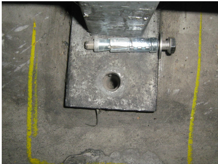
Foto: Voorbeeld van een niet juist afgedicht boorgat.
