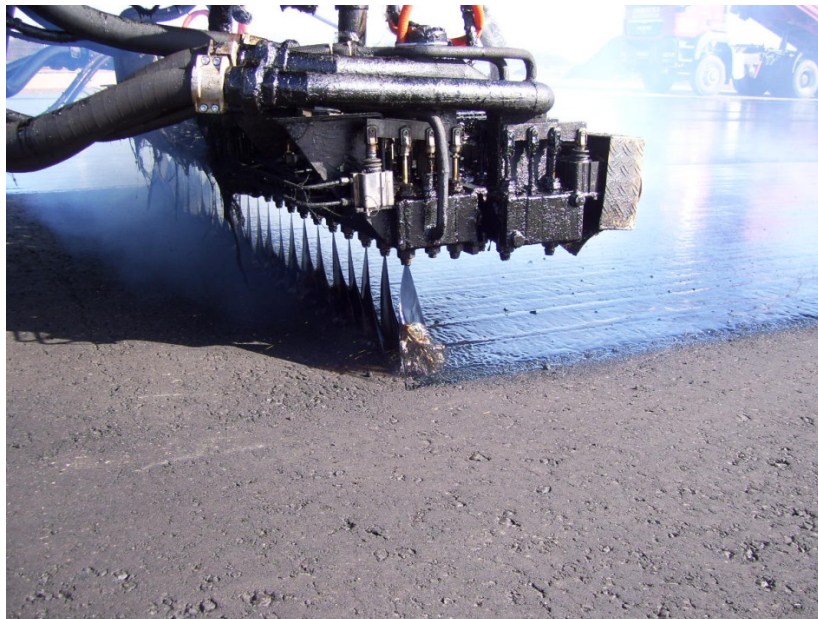
Foto: Aanleg vloeistofdichte asphaltconstructie.
