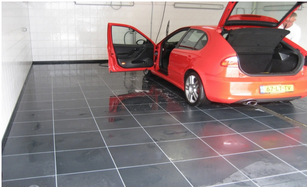
Foto: Vloer uitgevoerd met kunststof elementen.
