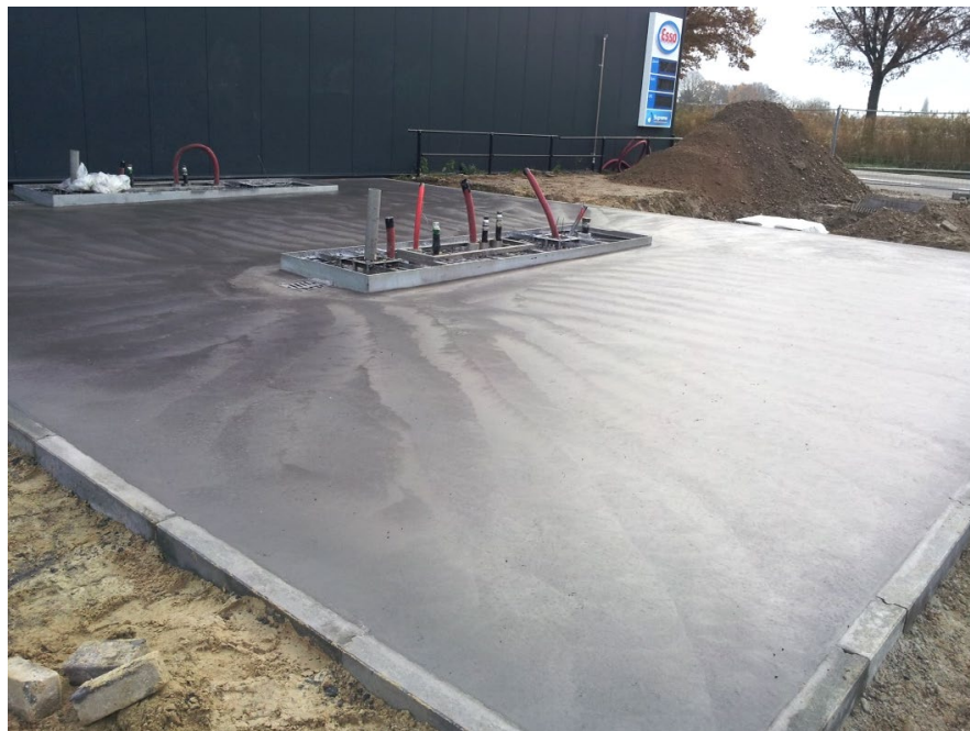
Foto: Aanleg van vloeistofdichte betonvloer.
