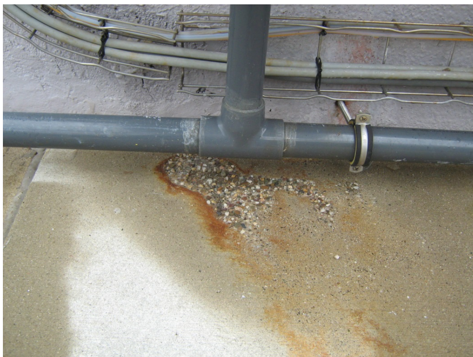
Foto: Voorbeeld van chemische aantasting.
